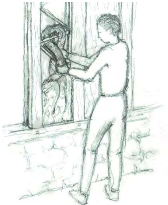
Illustration 32: Pose tressée : Soit les pailles sont imprégnées dans une barbotine puis torsadées, elle formes alors une La longue torche de torchis à l'état plastique est tressée sur le support. Soit elles sont réalisées avec une corde de paille sèche, la pose se réalise tressée sur le support. Finition d'égéalisation ou de remplissage avec un enduit de torchis plaqué.
