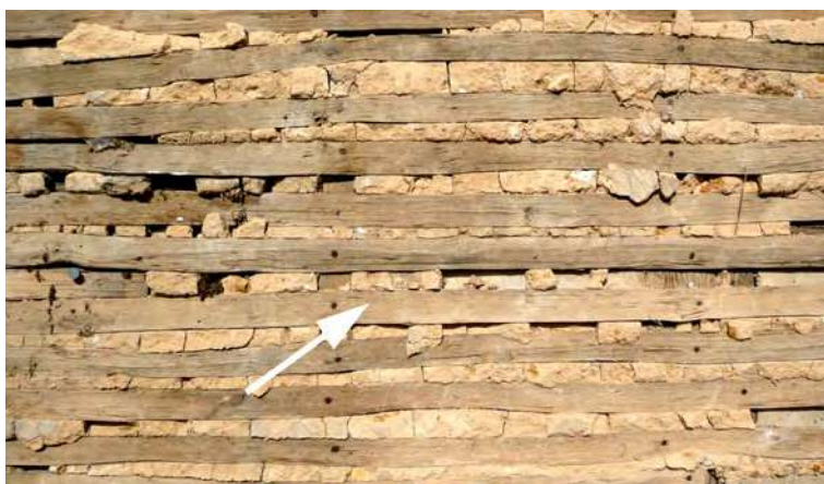
Illustration 17: un lattis découvert sur une face (Mylène Gajic)
