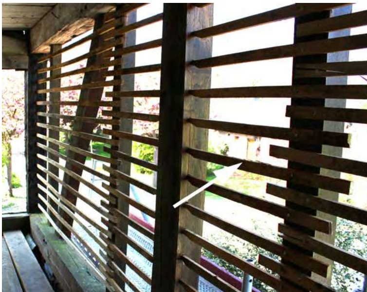
Illustration 16: Lattage formant lattis par endroit (Yan Minne)
